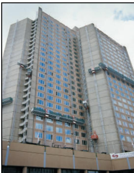
La plataforma de trabajo IZA 30/100 permite el trabajo en fachada, tanto en obra nueva como en rehabilitación de construcciones antiguas.
