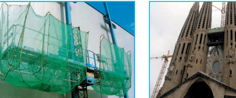
Sistema de protección ANTI-CAÍDA de objetos / Protection FROM FALLING objects / Système de protection ANTICRUISE d'objets
