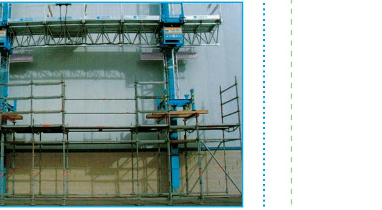
Montaje sobre pórtico tubular / Installation on tubular gantry / Montage sur portique tubulaire
